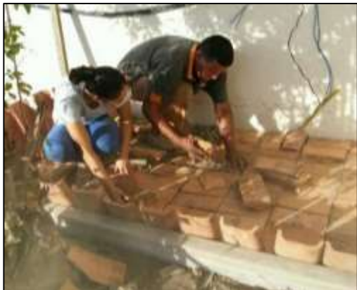
Figura 05- Construção, pelo EcoTime-CPF da UFSB, da composteira do campus X da UNEB– atividade colaborativa no município de Teixeira de Freitas- Ba (Jul.2016)
