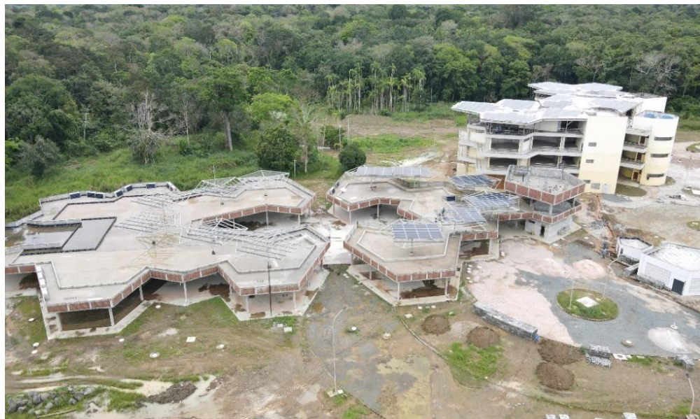
Figura VII.2: Imagem atual das obras do Campus Jorge Amado UFSB. Crédito da foto: Cláudio Souza da Silva (Engenheiro Civil – DINFRA/PROPA, 2021).
