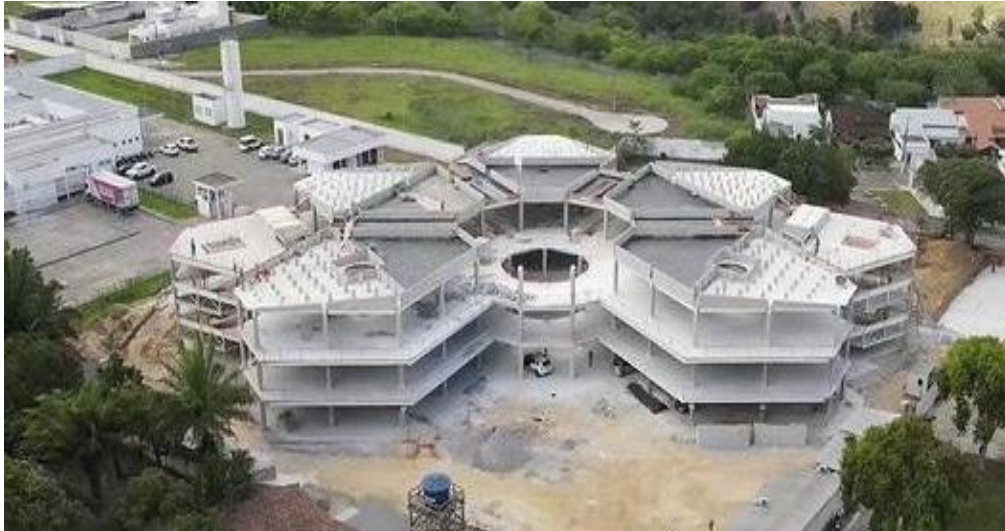
Figura VII.4: Imagem atual das obras do Bloco Pedagógico do Campus Paulo Freire UFSB. Crédito da foto: Cláudio Souza da Silva (Engenheiro Civil – DINFRA/PROPA, 2021).
