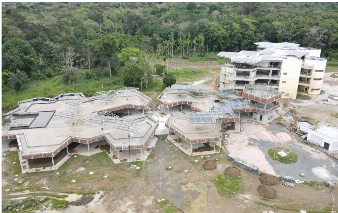
Figura 2: Imagem atual das obras do Campus Jorge Amado Crédito da foto: Cláudio Souza da Silva (Engenheiro Civil – DINFRA/ PROPA, 2021).
