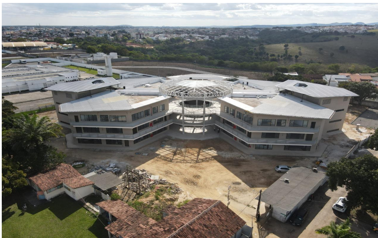
Figura 2: Obra de construção do prédio do Núcleo Pedagógico do Campus Paulo Freire na área do Complexo II.
