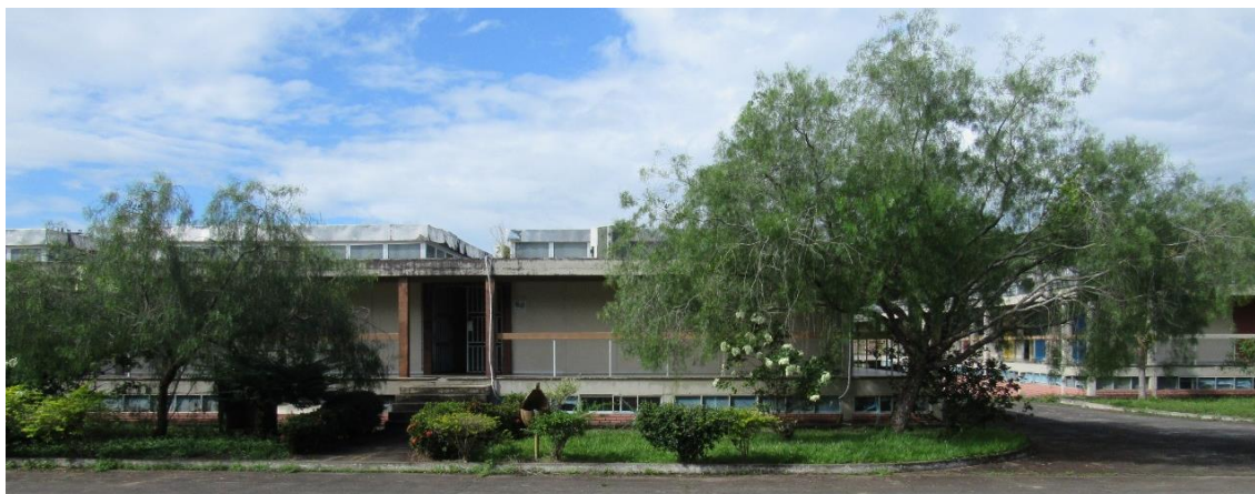
Entrada principal do CFCAF, conta também com entrada lateral com acessibilidade (Foto: Arnhold, 2020)
