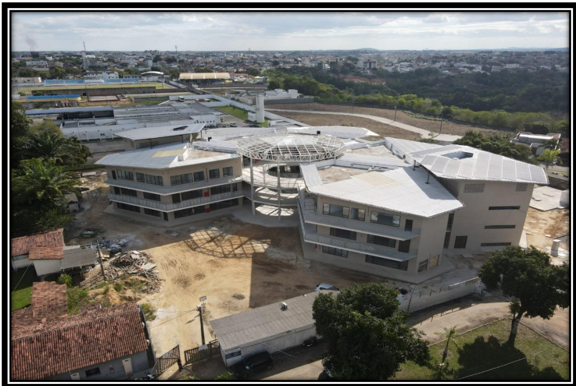
Figura 4- Obra de Construção do prédio do Núcleo Pedagógico do Campus Paulo Freire na área do Complexo 2
