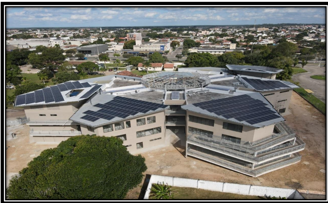
Figura 5 - Lateral da Obra de Construção do prédio do Núcleo Pedagógico do Campus Paulo Freire na área do Complexo 2
